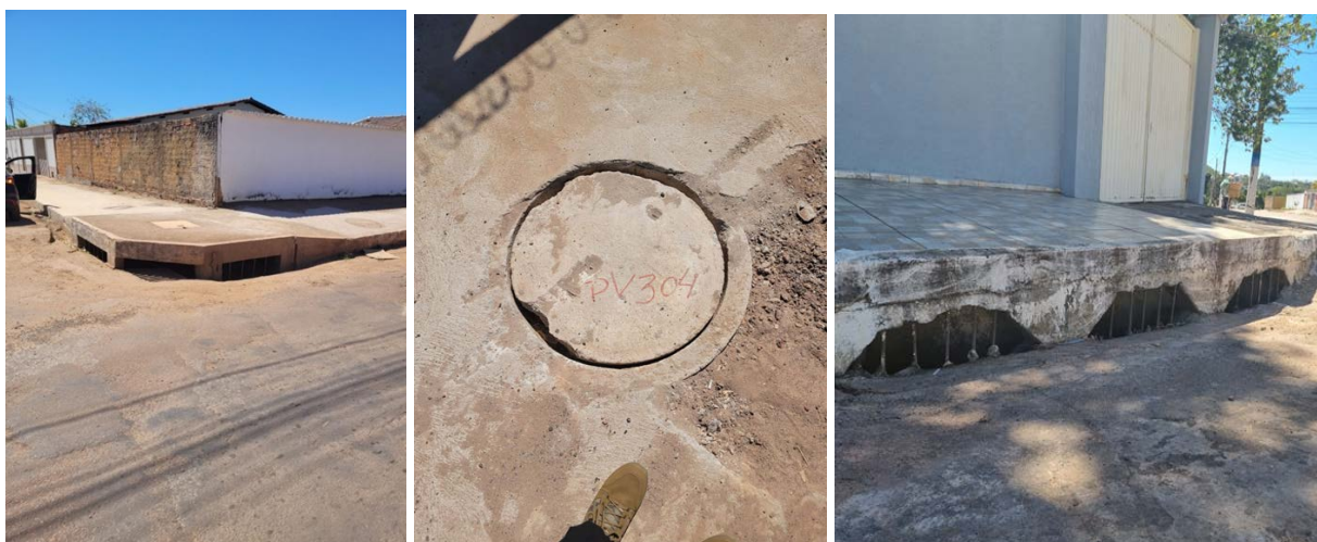
Figura 27 – Visita in loco, identificação dos elementos de drenagem – Cajueiros.
