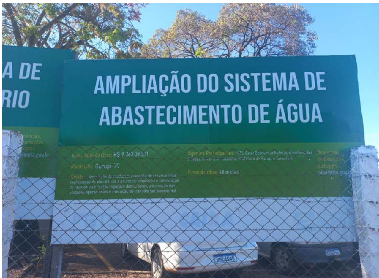
Figura 25 – Fotografia de placa de projeto de obra localizada nas dependências da ETA 001 de Gurupi.
