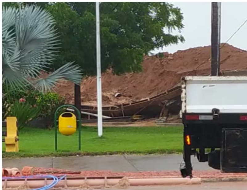
Muro caiu após chuva forte em Gurupi — Foto: Divulgação
